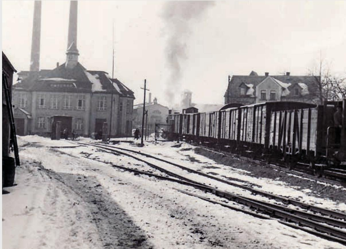
Die „Friese-eigene“ Betriebsbahn von Kirschau nach Wilthen wurde in Rekordzeit 1905/1906 erbaut, um den riesigen Bedarf an Rohstoffen, Baumwollabfällen, Jute und dem Energieträger Kohle effizient zu organisieren. Täglich mussten zwölf Eisenbahnwaggons zu je zehn Tonnen entladen werden. Bei der Realisierung der Trasse wurde das technische Problem einer Strecken-Steigung von 1:27 ohne Zahnradantrieb bewältigt, auf
