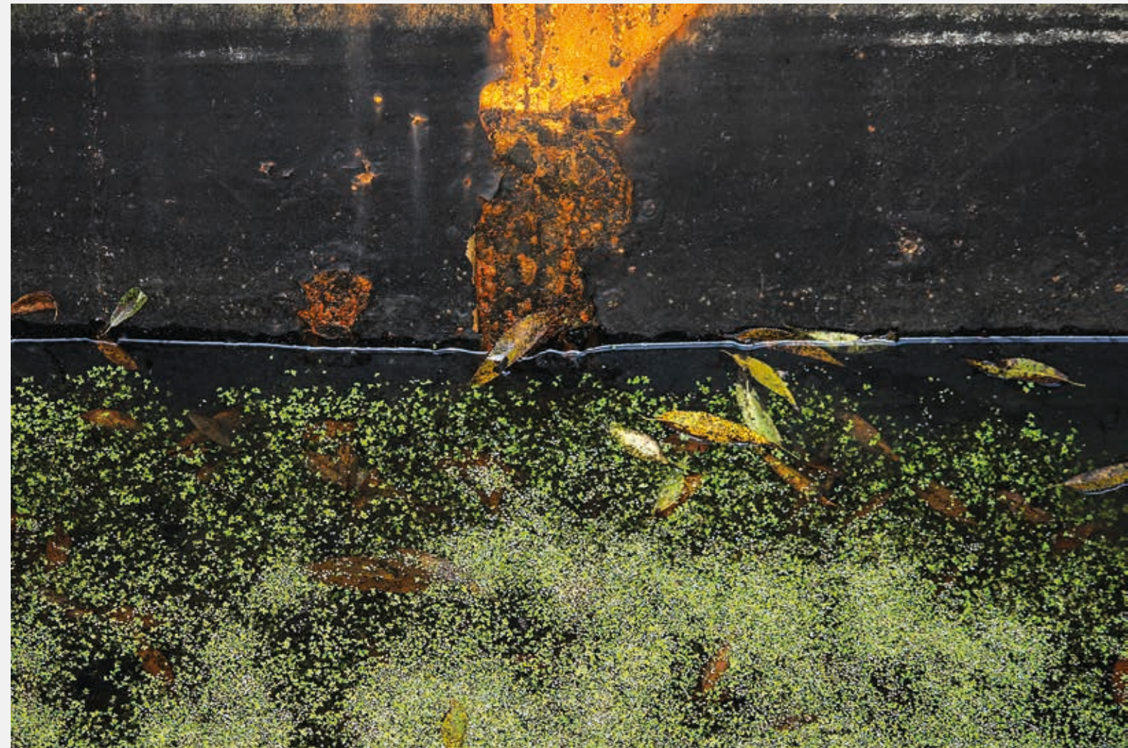
Mikulášovice (deutsch Nixdorf) im Kreis Děčín in Tschechien. Stillgelegte Kläranlage in der ehemaligen deutschen Gummibandfabrik. Photographien Holger Wendland
